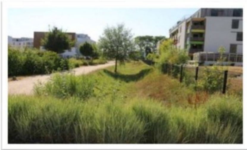
Noüe végétalisée, lotissement Sainte-Anne, Strasbourg. Source : AERM
