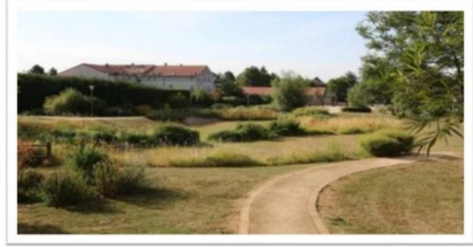
Espace vert décaissé, recueille et infiltre les eaux de pluie, parc de l'Archyre, Scy-Chazelles. Source : AERM
