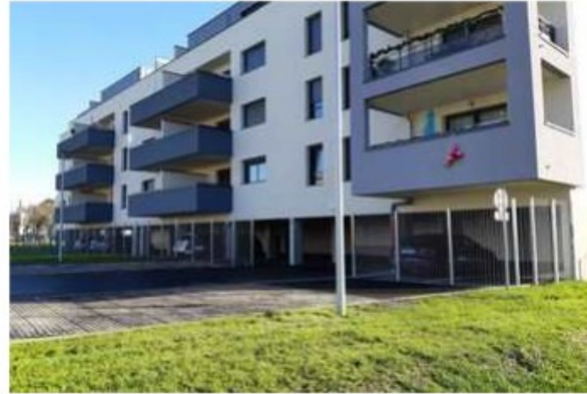
Construction de logements résilients (RDC laissant circuler l'eau en cas d'inondation), Le Ban Saint-Martin Source : AERM
