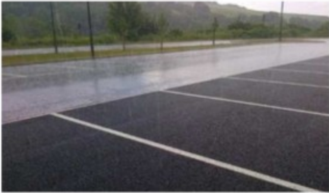
Parking en enrobé poreux Sierck-les-Bains. Source : N. Venandet, AERM
