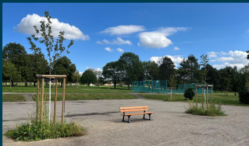
Désimperméabilisation et plantation d'arbres au sein des anciens terrain de tennis
