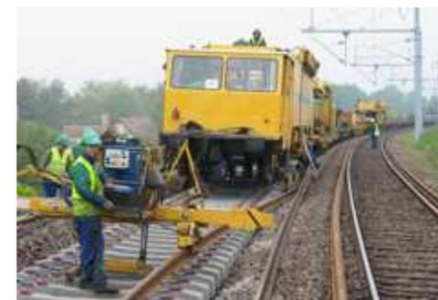
Longs Rails soudés sur traverses béton
