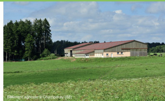
Bâtiment agricole à Chamodray (88)
