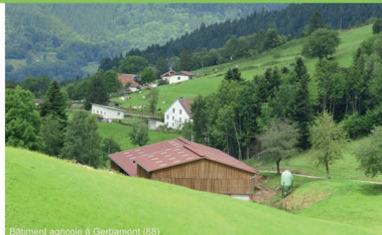
Bâtiment agricole à Gerbamont (88)
